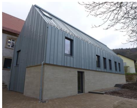
Rückansicht des neuen Gemeindehauses
