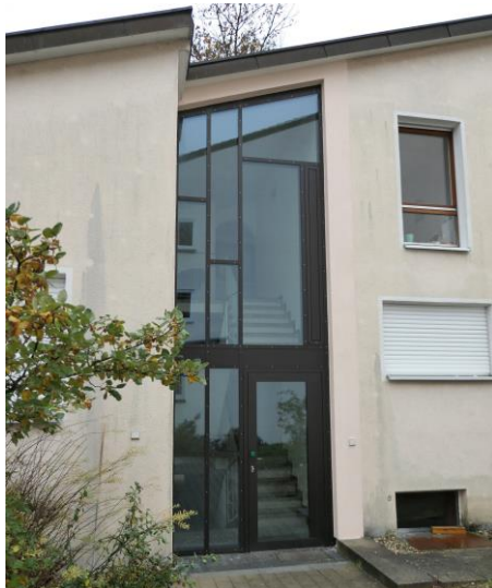
Die neue Treppenhaus-Glasfassade des Pfarrhauses
