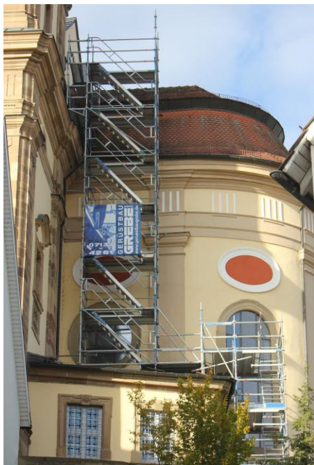
Gerüst zur Untersuchung der Dachschrägen
