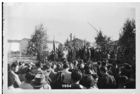
Feierliche Grundsteinlegung Kirche Pax Christi
